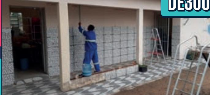
Escola Nossa Senhora de Fátima, de Linha Campo Grande, recebeu uma ampla reforma em diversas frentes. Houve a substituição total da cobertura, dos assoalhos de madeira, dos pisos e revestimentos cerâmicos, dos forros de PVC e das esquadrias do prédio, além de outras pequenas reformas e pinturas.
