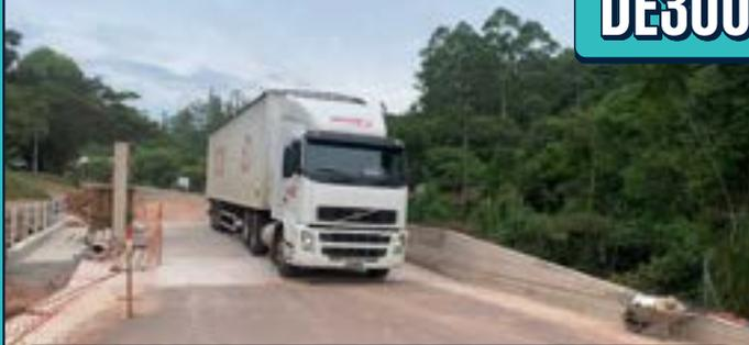
Com a parceria inédita, uma nova ponte de concreto com dez metros de comprimento e 12 metros de largura foi edificada na ERS-422, em Linha Brasil. Com orçamento de aproximadamente R\$ 685 mil, a nova ponte, que substituiu um vão de madeira com mais de 80 anos, recebeu R\$ 307,6 mil em recursos municipais e o mesmo valor em contrapartida do Governo do Estado, através da dedução de impostos.
